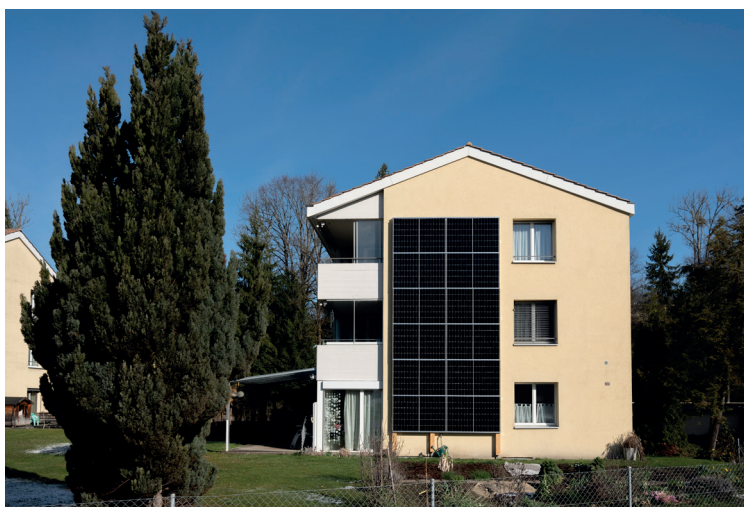
An der Zelgstrasse 47 nutzen die Besitzer der Eigentumswohnungen an der Fassaden-Photovoltaikanlage produzierten Strom gemeinsam. Die NetZulg AG begleitete das Projekt und unterstützt mit dem Produkt DachStrom NetZulg .
