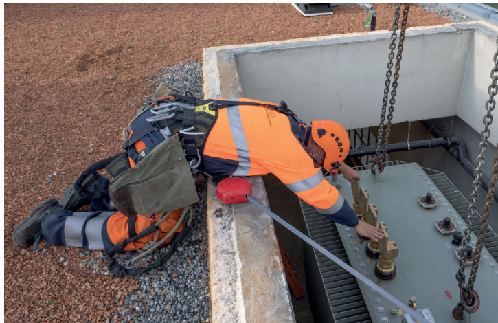
Die Montage einer Trafostation ist eine Teamaufgabe für die ganze Gruppe Strom.
