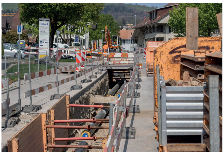
Die NetZulg AG baute mit der Hauptverbindungsleitung in der Glockenthal- und Unterdorfstrasse ein Schlüsselbauwerk zur Fernwärmeversorgung von Steffisburg Dorf.
